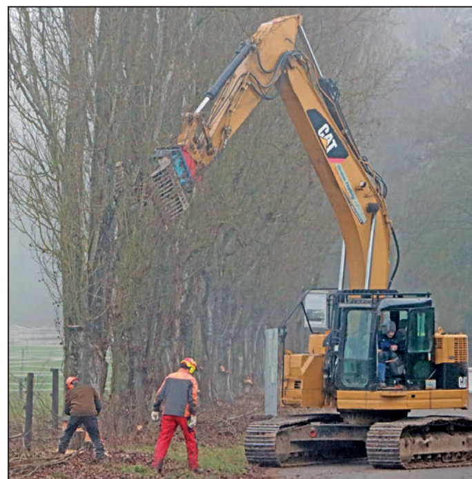
Mit schwerem Gerät rückten am 16.02.23 Mitarbeiter des städtischen Bauhofs an, um elf Pappeln entlang des Radweges aus Sicherheitsgründen zu fällen.
