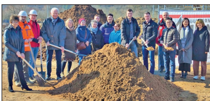
Spatenstich für den neuen Firmensitz der MIEBO Tech Export mit allen Mitarbeitern sowie Geschäftsführer Dongwei Chen (3.v.re.), Bürgermeister Markus Schenk und Christoph Mündlein vom Bauamt Eibelstadt (5. und 6. v.re.) sowie v.li. Inge Krämer, Sparkasse Mainfranken, Izmail Özdogan und Mathias Amling, Josef Amling GmbH und Architekt Klaus Podack, Zweiflingen. Foto/Text: Antje Roscoe
