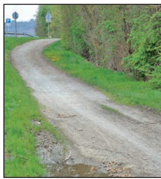
Trotz knappen Geldes und inzwischen stark gestiegener Kosten will die Gemeinde Winterhausen den Radweg nach Goßmannsdorf ausbauen. Noch heuer soll damit begonnen werden.
