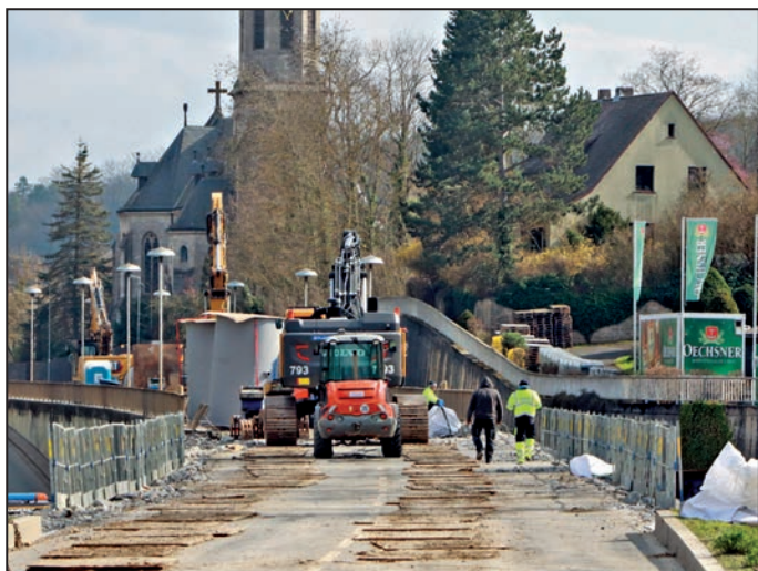
Die Vorarbeiten zum Abriss der Überführung laufen auf Hochtouren. Bild: W. Meding
