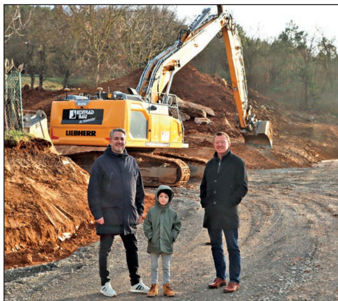
Bürgermeister Peter Juks (rechts) informiert seinen Stadtratskollegen aus Goßmannsdorf, Johannes Klinke, über die Bauarbeiten im Gebiet oberhalb des Lehmgrubenweges.
