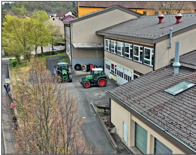
Auf dem Hof der Berufsschule in Ochsenfurt soll eine neue Werkstatthalle entstehen, um nach einer teilweisen Dachsanierung einen neuen Bereich für die Praxisausbildung an modernen Landmaschinen zu bauen. Foto: Tobias Kiesekamp
