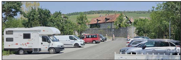
Es geht voran bei Bauabschnitt eins zur Umgestaltung des Maintorvorplatzes in Eibelstadt. Die neuen Parkplätze werden schon genutzt. Foto: Antje Roscoe
