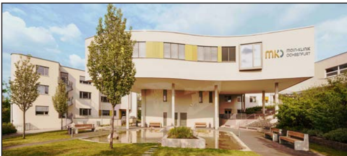
Der Landkreis Würzburg saniert die Main-Klinik in Ochsenfurt umfassend. 2025 wurde der erste Bauabschnitt mit der baulichen Erneuerung von insgesamt 46 Zimmern sowie neuen Bereichen unter anderem für Labor, Physiotherapie und Haustechnik fertiggestellt. Ab Ende 2026 soll die energetische Modernisierung in einem zweiten Bauabschnitt bis 2030 erfolgen. Foto: Nicole Grasmann
